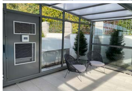
Links: Die Bauherren finden immer einen wohltemperierten Raum vor, wenn sie die Halle betreten. Rechts oben: Die Entfeuchtungs-Wärmepumpe ist in der Wand des feststehenden Elements integriert. Rechts unten: Die Lüftungsgitter der Entfeuchtungs-Wärmepumpe.
